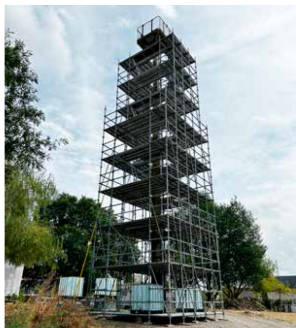
Le phare, en cours de rénovation
