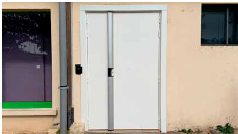
Nouvelle porte du tennis club
