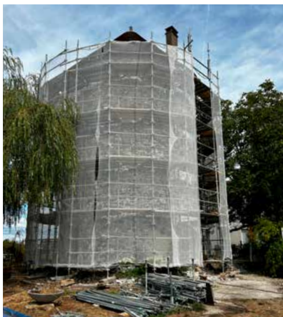
Le moulin, en cours de rénovation
