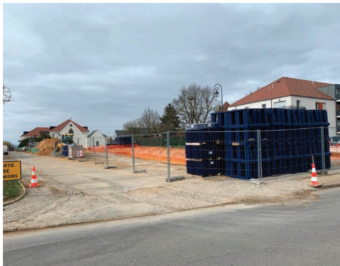
Blocs bassin de retenue
