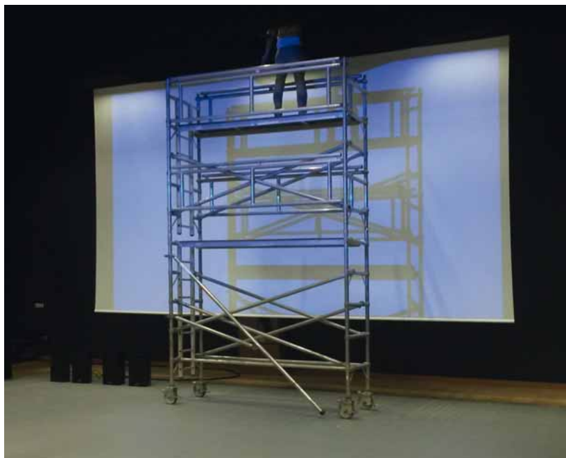
Ecran en cours de montage
