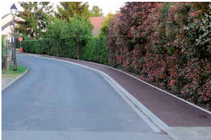
Réfection du trottoir pavé des Ermites
