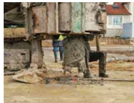
Viser juste : Zouhir à la manœuvre ... sous l'engin ! Remarquer le repère ... rouge !
