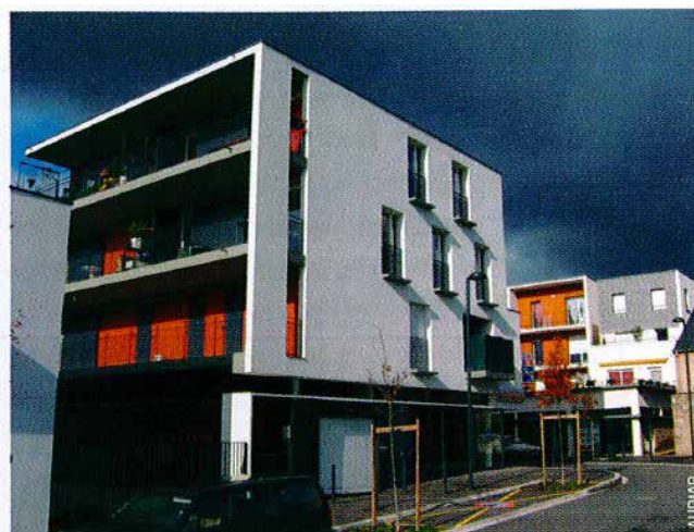
Les immeubles « plots » R+3
